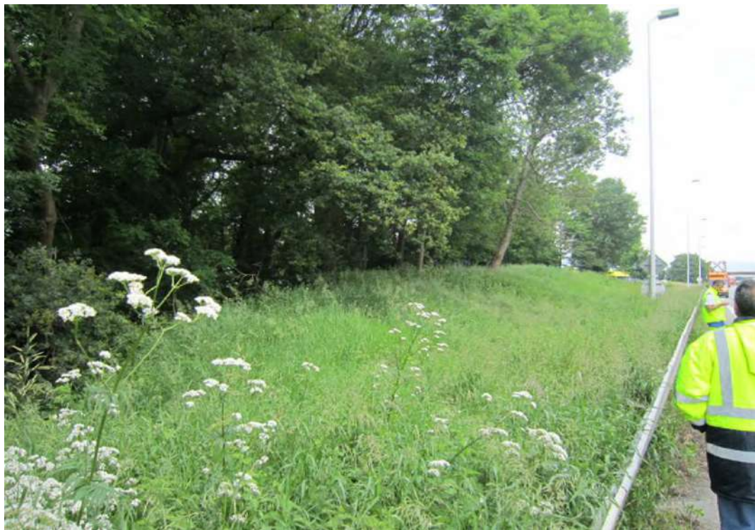
PHOTO 1 : VUE EN RIVE OUEST
