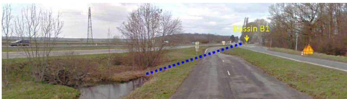
FIGURE 22 : EXUTOIRE DU BASSIN B1
