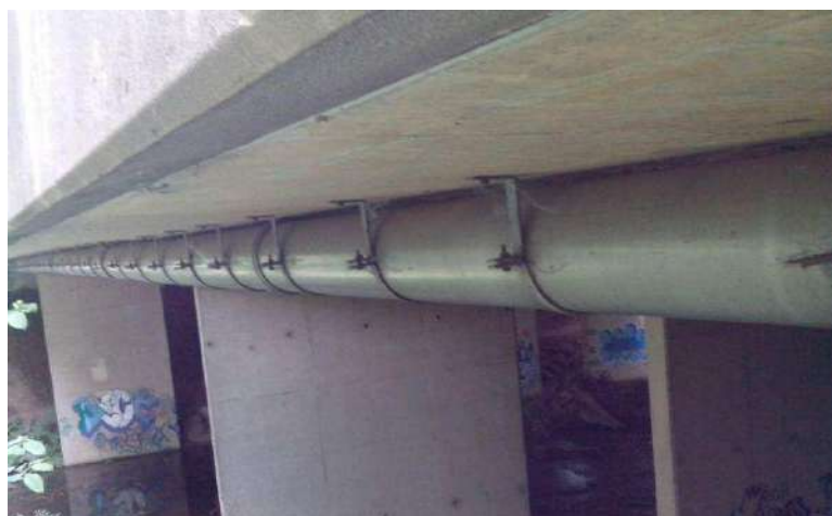
FIGURE 16 : PASSAGE DU COLLECTEUR EN ENCORBELLEMENT
