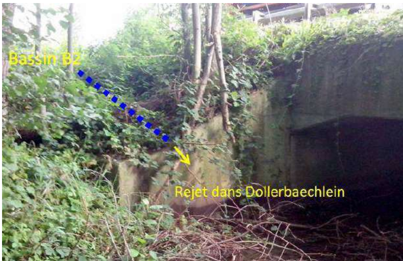
FIGURE 24 : EXUTOIRE DU BASSIN B2
